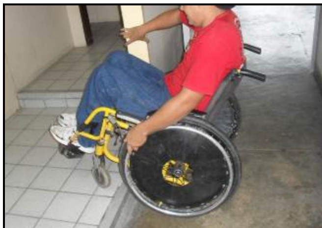
Figura 09. Fotografia do acesso ao banheiro dificulta a entrada do usuário de cadeira de rodas. Fonte: Arquivo pessoal, 2010.
