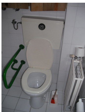
Figura 17 – Banheiro privado - 2º pavimento.
