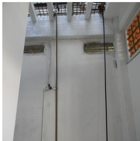
Figura 2 – Paredes e Janelas da galeria B do Presídio.
