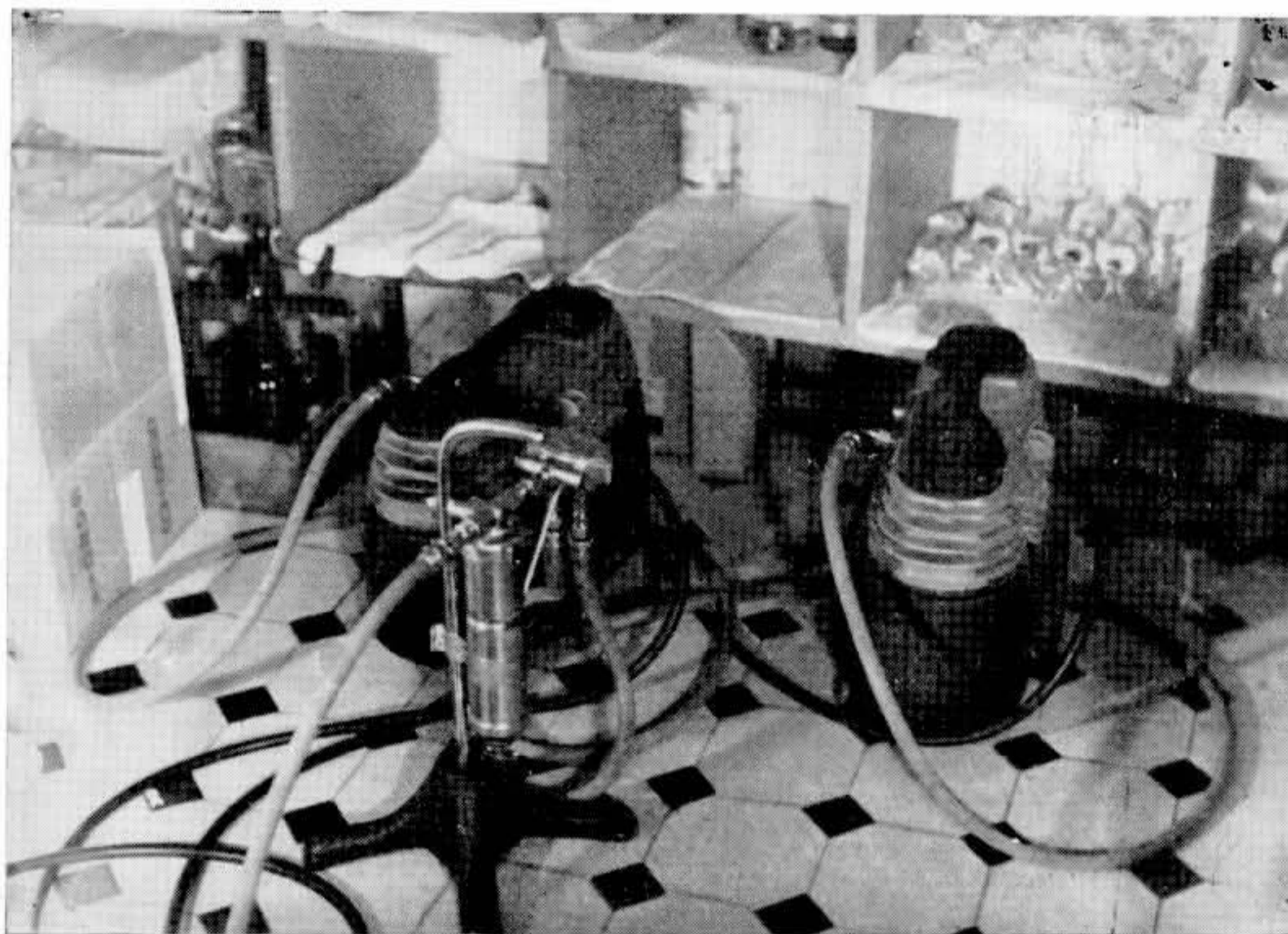
Fig. 19 — Compressores para acionar o pulmo-ventilator, colocados num compartimento longe da sala de operações, para evitar o incômodo produzido pelo barulho dos motores.
