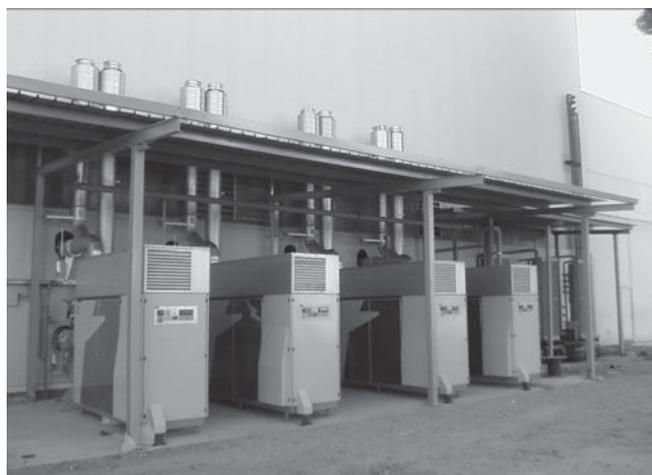
Figura 9. Cogeração com microturbinas a GLP instaladas na Cerâmica Mediterranea.
