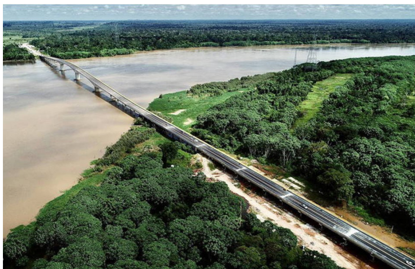
Figura 4. Ponte sobre o Rio Abunã.
