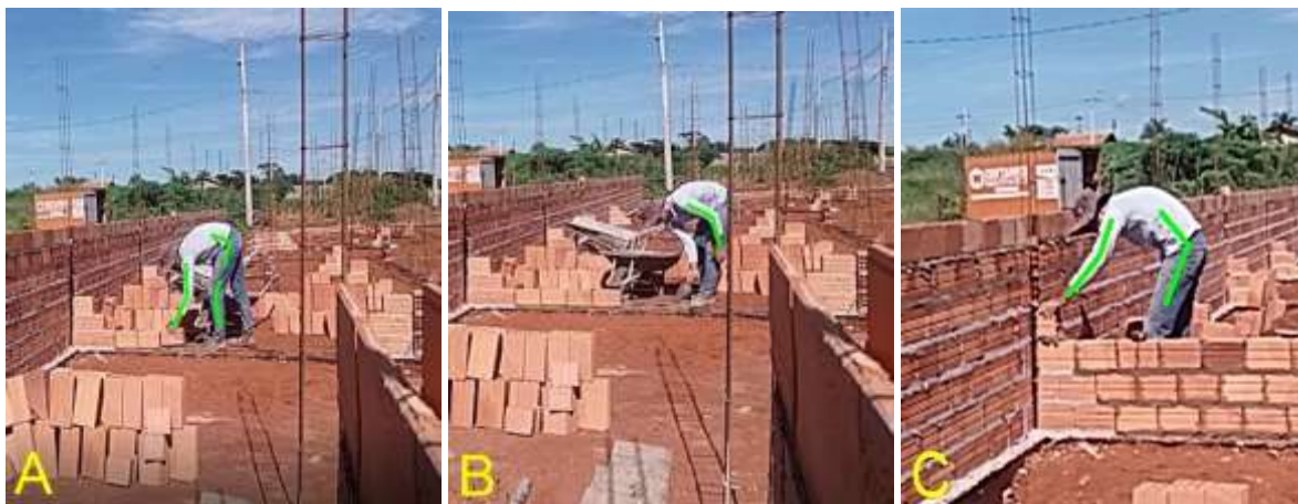
Figura 3 – Execução da elevação da alvenaria (fiadas iniciais)
