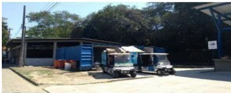
Figura 13. Local para implantação do abrigo de resíduos perigosos.
