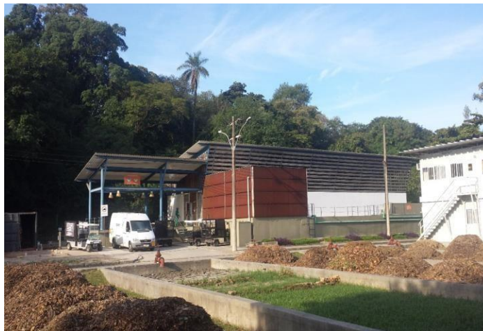
Figura 8 Área do Depósito dos Resíduos do Produtos Perigosos da Fiocruz
