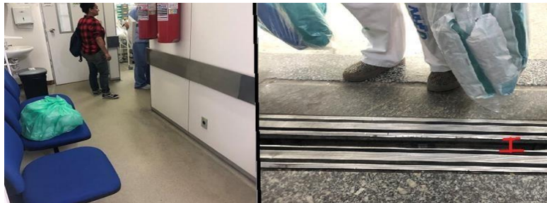
Figura 4. Acesso à Unidade A da Maternidade e desnível do elevador. (Autores, 2019)
