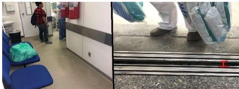
Cifra 4. Acceso el Unidad EL desde Maternidad y desnivel de ascensor. (Autores, 2019)
