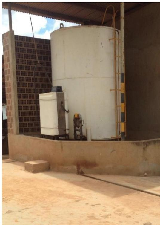
**Figura 5.** Sistema de contenção do efluente contaminado. Fonte: Autor (2017).
