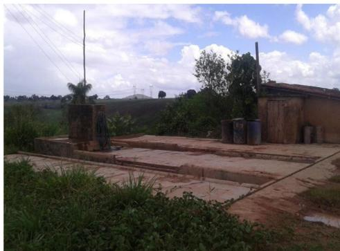
**Figura 6.** Dique de contenção de óleo combustível e separação de água e óleo. Fonte: Autor (2017).
