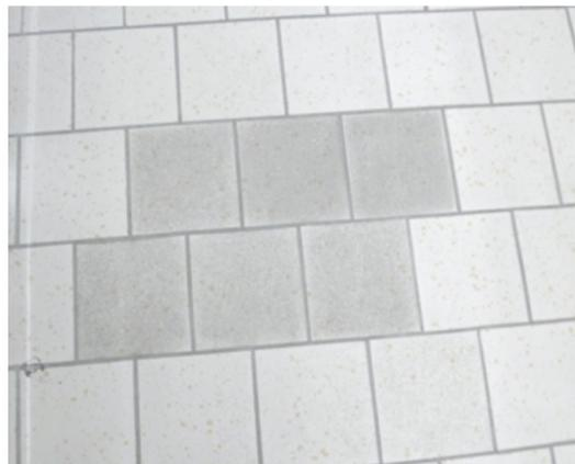
**Figura 1.** Manchas fortes na superfície, levando a grandes transições de cores em pisos (esquerda) e fortes efeitos visíveis e localizados de mosaico (direita).
