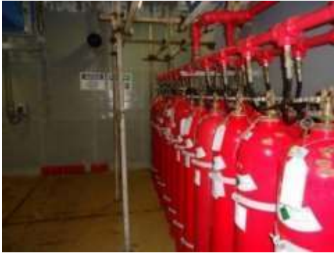
Figura 7. Sala de baterías de CO 2
