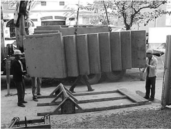
Figura 5: Cavalete de madeira usado para apoiar os lances da escada antes do içamento.
